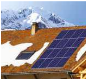
Bâtiment mal isolé
